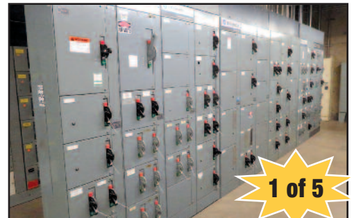
Allen Bradley Centerline 2100 M.C.C.
